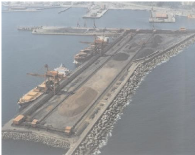
Gijon—EBHI Terminal (S side of Dique Principe de Asturias)
